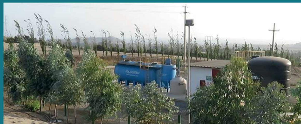
**Planta de Tratamiento de agua residual PTAR.** El agua residual proveniente de campamentos y comedor es direccionada hacia la planta de tratamiento de agua residual, en donde es tratada mediante un proceso biológico (lodos activados).
