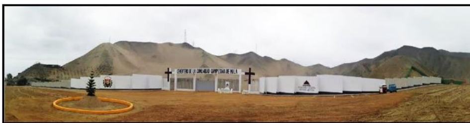
AMPLIACION FRONTAL DE CERCO PERIMETRICO Y NIVELACION VIA DE ACCESO AL CEMENTERIO DE LA COMUNIDAD CAMPESINA DE MALA – SAN
