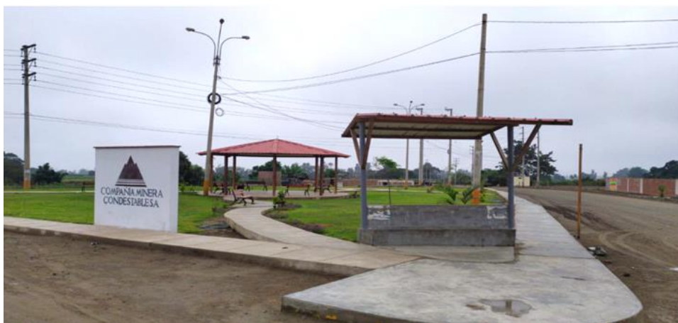
CONSTRUCCIÓN DE PARADERO EN PARQUE ANEXO 27 DE DICIEMBRE
