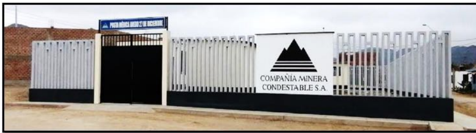
REMODELACIÓN E IMPLEMENTACIÓN DE PUESTO DE SALUD ANEXO 27 DICIEMBRE PARA GESTIÓN DE ATENCIÓN PERMANENTE.
