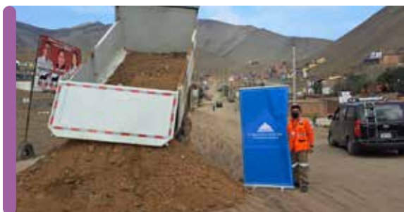
Donación de afirmado para mantenimiento de vías
