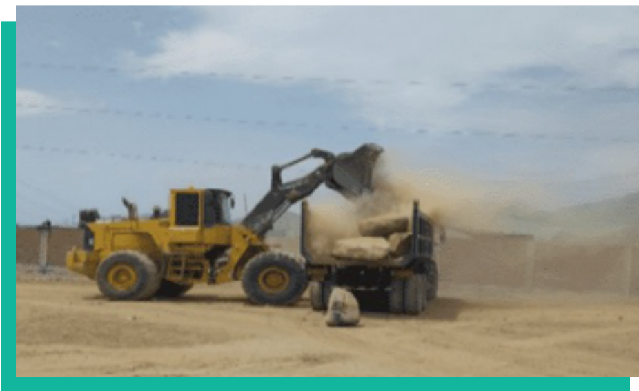
Apoyo con maquinarias para el traslado de rocas para el reforzamiento del río Mala
